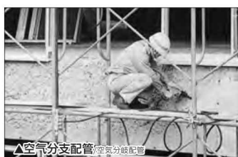
▲空气支配管/空気分岐配管
